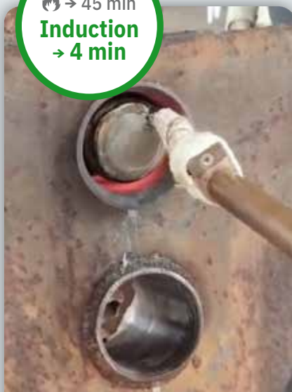
HEAT EXCHANGER TUBE REMOVAL - EXTRACTION DU TUBE D'UN ÉCHANGEUR THERMIQUE Inductor Heat Tube D50 Powerduction 160LG
